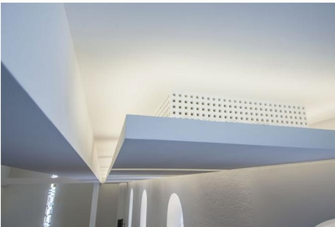
Deckensegel aus Knauf Akustikputzträgerplatten Tectopanel mit Akustikputz absorbieren den Schall in der Kirche.
