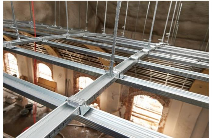
Die gebogenen Grundprofile der Unterkonstruktion wurden im Werk in den erforderlichen Radien vorgefertigt und passgenau geliefert.
