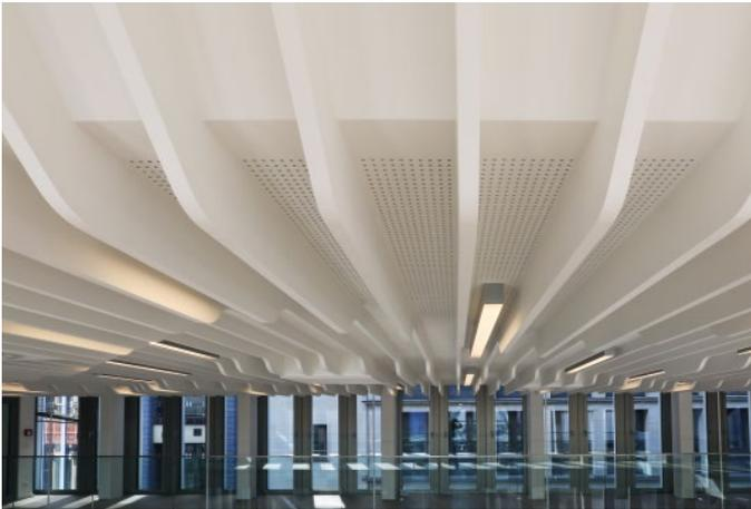
Perfekte Integration des Deckenkoffers durch seitlich hochgeführte Lamellen.
