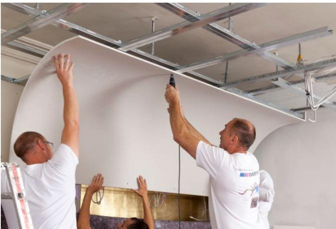
Die Trockenbauer fertigten das Deckensegel oberhalb der Sitznischen in der Lounge aus vorgefertigten Platten an, um die Montagezeit zu minimieren.
