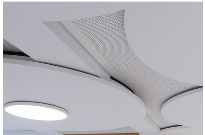
Die neue Decke staffelt sich in drei Ebenen in die Höhe und kaschiert dabei auch die tief liegenden Stahlbetonunterzüge. (Foto: Knauf)
